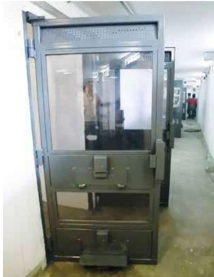
Puertas con doble sección de Secure Poly, doble pasa comidas y lámina multi perforada en la parte superior.
