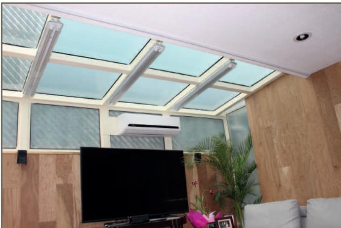
Domos de alta seguridad fabricados con Secure Glass y laminados de control solar que cumplen con las normas ASTM permitiendo el paso de luz natural, rechazando hasta un 90% de calor y deteniendo hasta un 99% de rayos UV.
