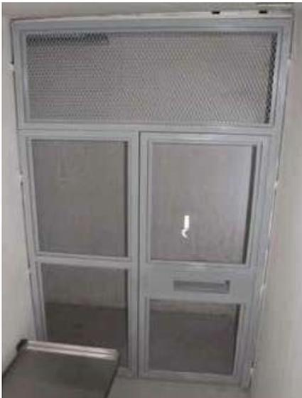
Puerta y fijo con secciones de Secure Poly, compuerta para esposar o pasar documentos y rejilla de ventilación en la parte superior.
