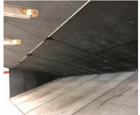
**Embudo de Recepción de proyectiles angulado y con Hexágono receptor de proyectiles en acero balístico con escotillas de limpieza.**
